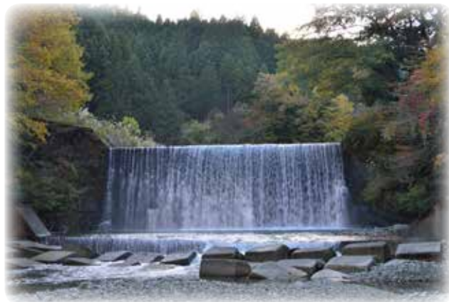
小水力発電調査対象地点
