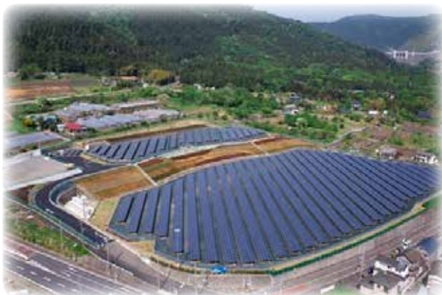
太陽光発電施設
