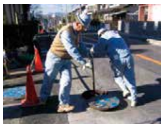
水道管布設工事現場管理
