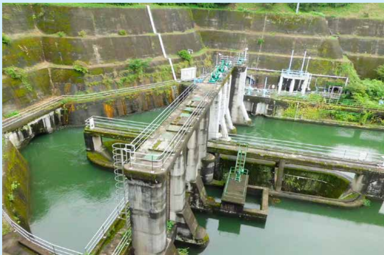
写真：津久井分水池
