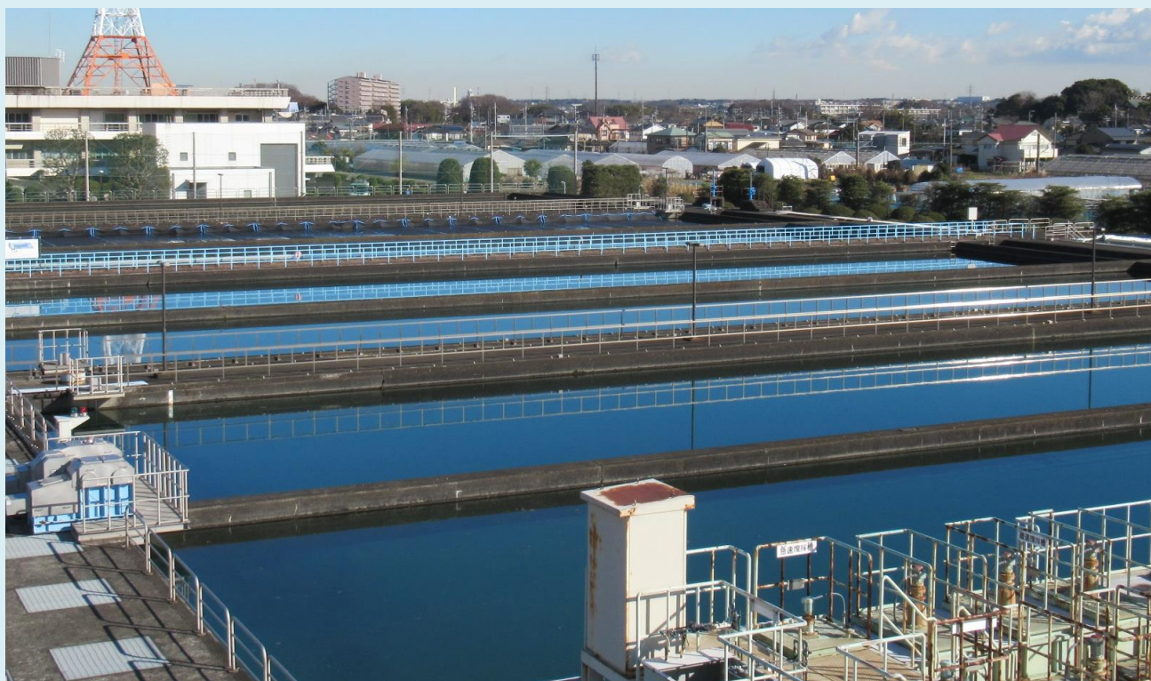
写真：寒川浄水場（沈でん池）
