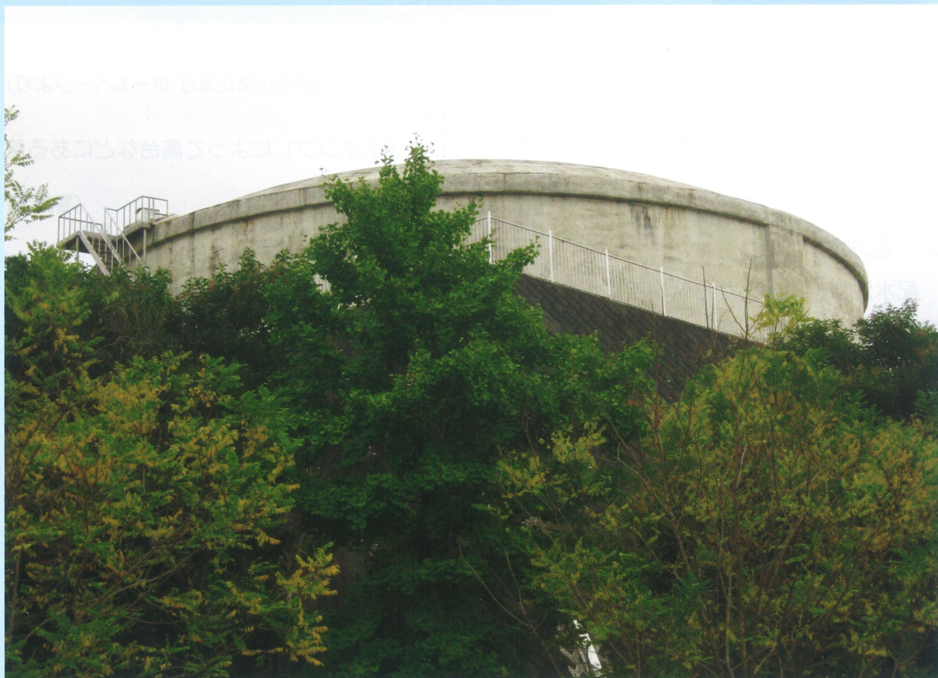
写真：腰越配水池(写真1)
