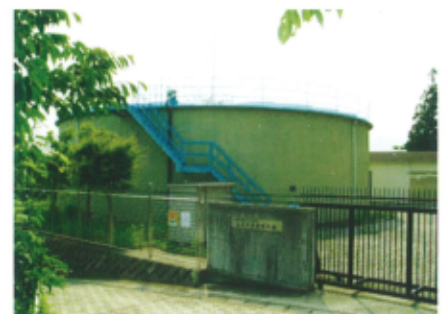
上荻野東部配水池
