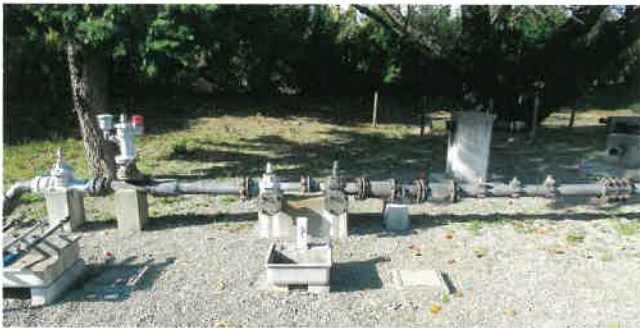
水道管配管コーナー (水道記念館)
