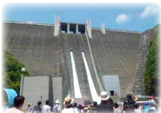
宮ヶ瀬ダムの観光放流を見上げる
